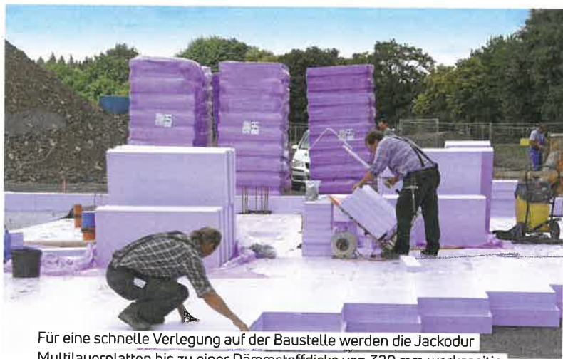
Die klassische Außendämmung ist universell einsetzbar – auch im Grundwasser. Sie ermöglicht selbst hohe Dämmdicken ohne Innenraumverlust. Der Tauwasserpunkt liegt außerhalb der Betonwand, Wärmebrücken lassen sich leicht vermeiden. Knecht Kellerbau
